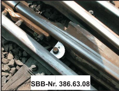
Kontaktzahnscheibe / Contact Disc Type 2 (700.2K)
