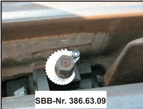
Kontaktzahnscheibe / Contact Disc Type 3 (700.3K)
