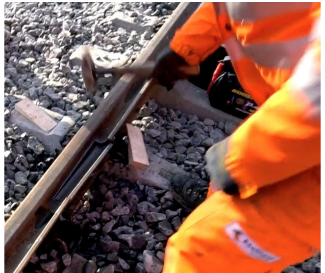
Abgetrennte Rille wird mit Hammer herausgeschlagen.
