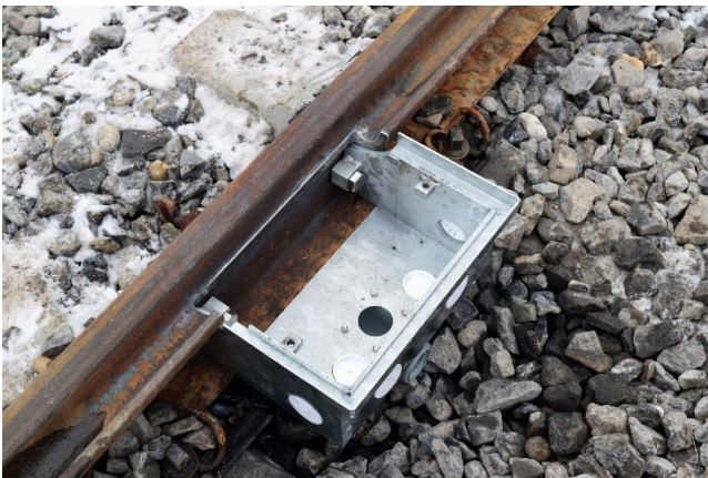
Kasten montiert an abgetrennter Rille, noch ohne Achszähler.
