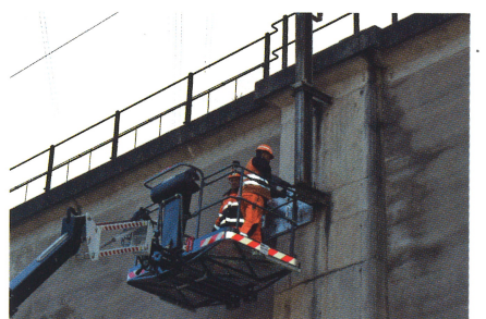
Montage von Fahrleitungskonsolen
