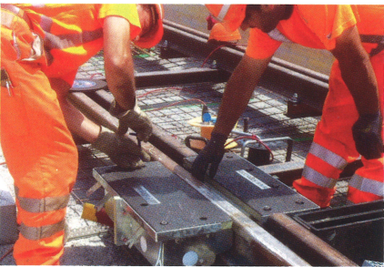
Montage von Gleisanschlusskästen
