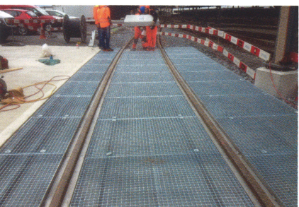
Montage von Ölauffangwannen
