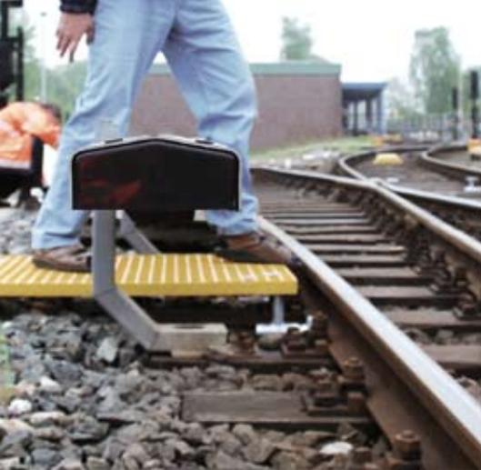
Zum Überqueren an Stromschienen
